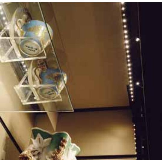
Na foto, detalhe das "barras de luz" com pontos de fibra ótica, aplicadas nas vitrines que necessitaram de luz pontual e luz difusa.
